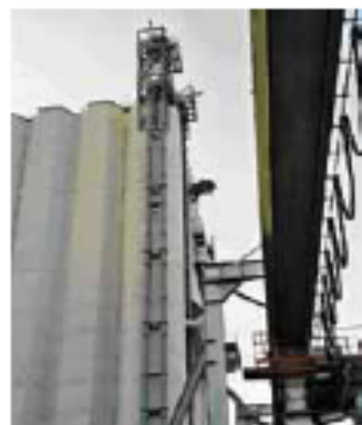
Abb. 1: Becherelevator zum Befüllen von Silos.
